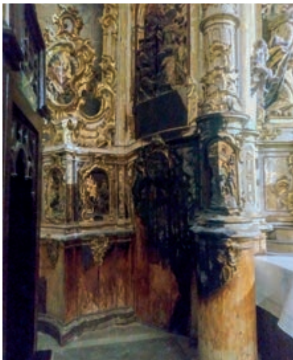
Agents de degradació III: intervencions de l'home. Cremades profundes per font de calor
